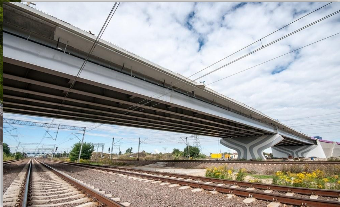
Warszawa, wiadukt; 1570 Mg
