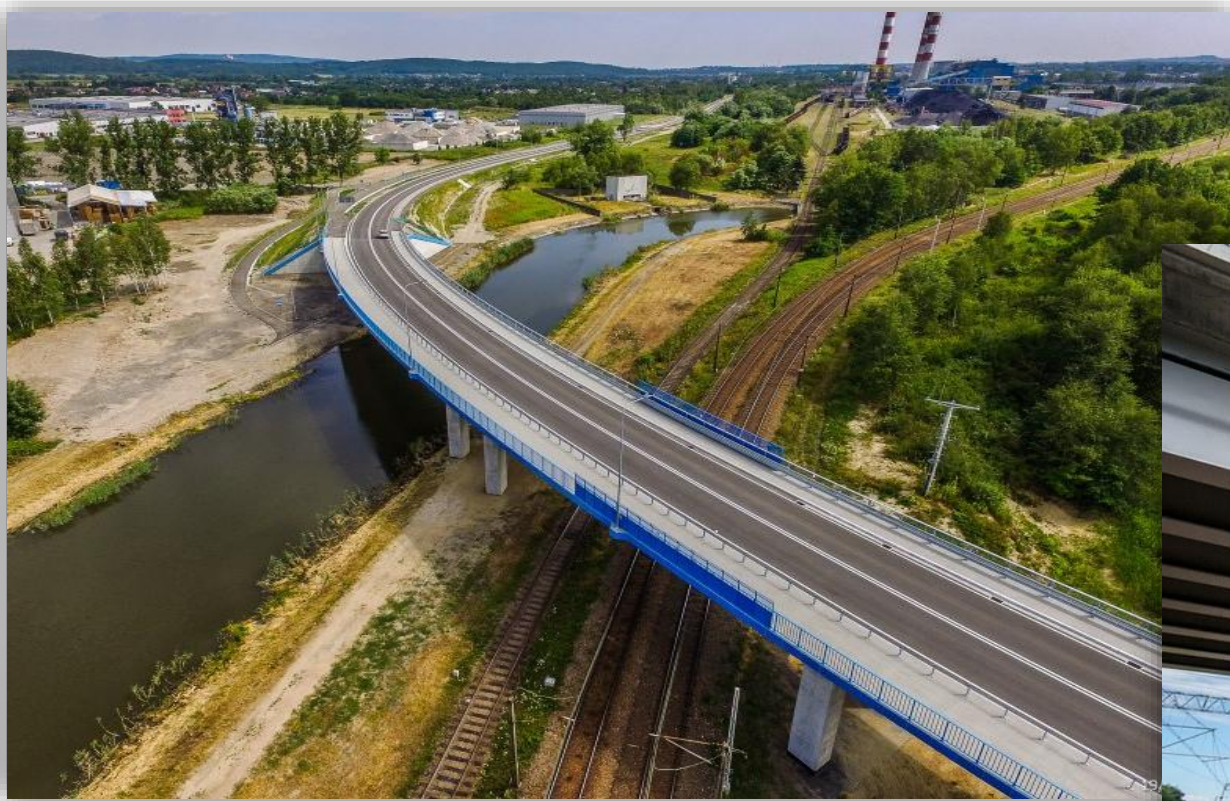
Skawina, obiekt drogowy
