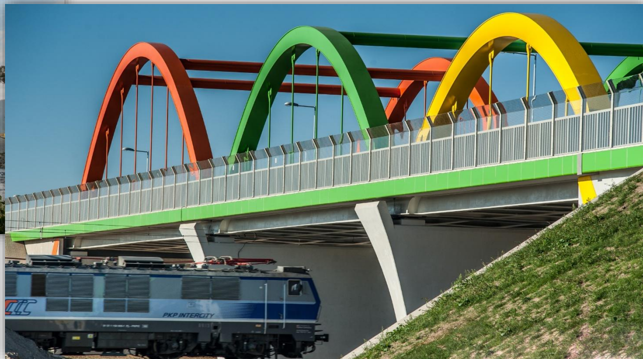
Wiadukt kolejowy, Swarzędz; 340 Mg.
