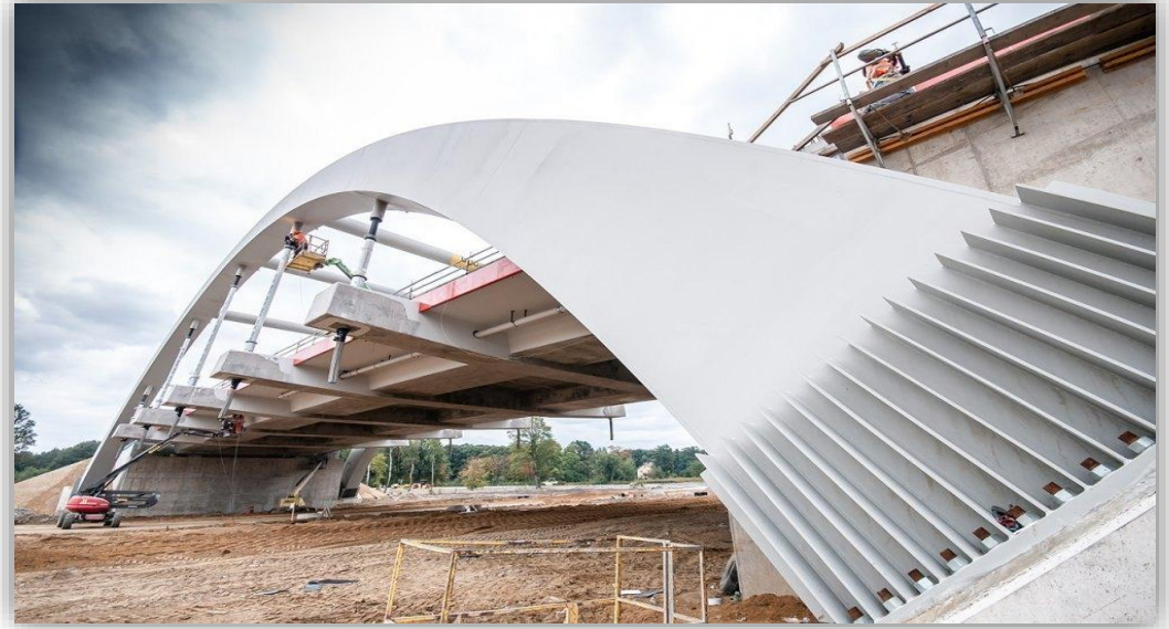
Wiadukt kolejowy WD-124 Dębica, autostrada A4; 507 Mg
