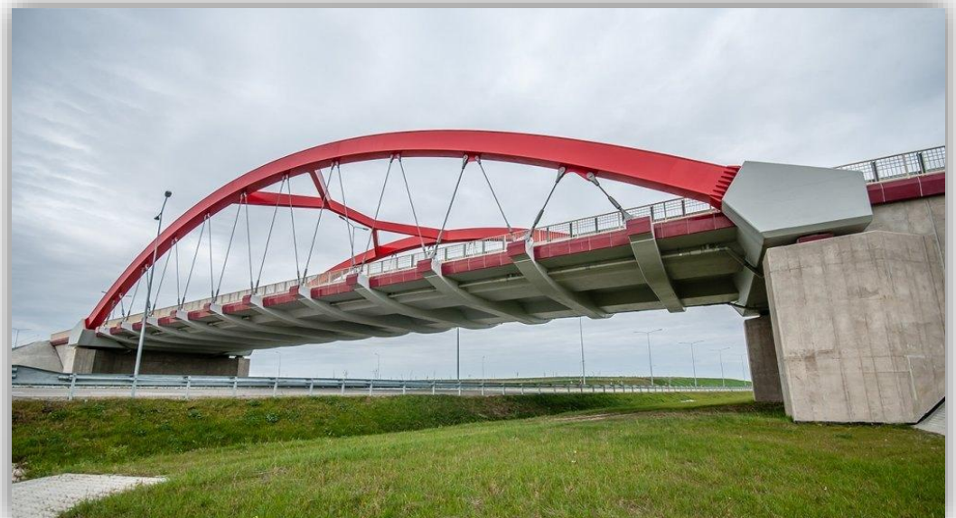
Autostrada A-4 - wiadukt Korczowa; 560 Mg
